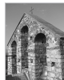
Mur clocher à trois arcades
