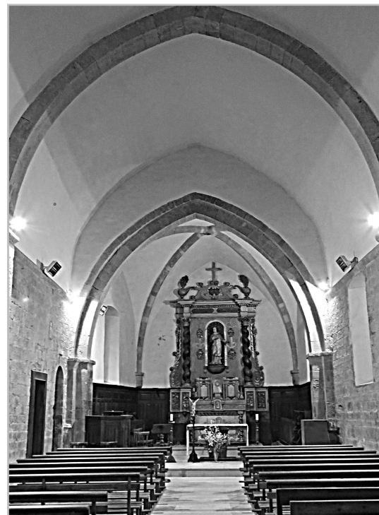
Voûte de la nef du type berceau plein cintre brisé
