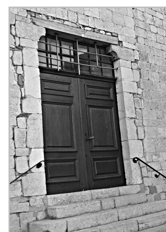
Porte d'entrée (actuelle) construite ultérieurement au XIV e s.
