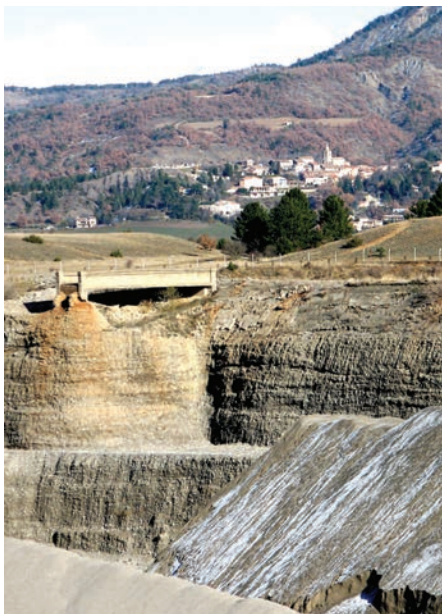
Carrière SAB du Beynon - Pont de l'ancien canal d'aménée de l'usine hydroélectrique - Au loin Claret
