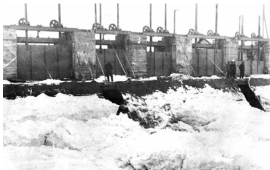
Chambre d'eau gelée le 14 janvier 1926
