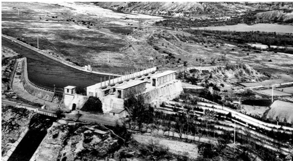
Chambre d'eau, déversoir, salle des vannes et conduites forcées
