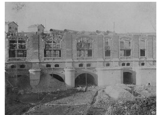
Construction de la salle des machines 1909
