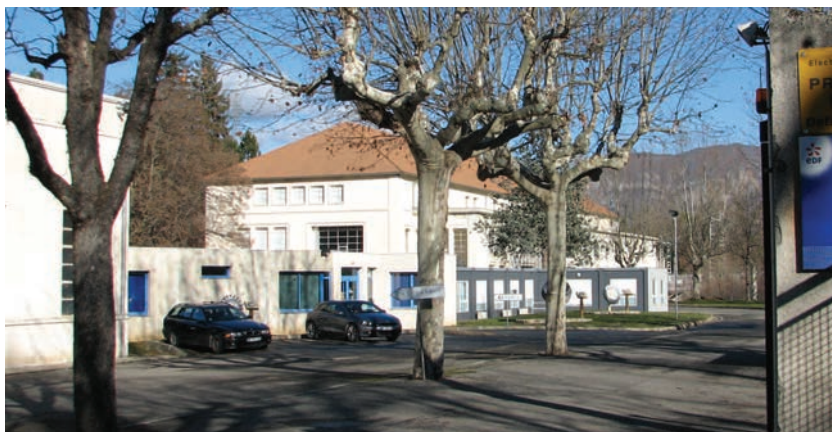
Entrée de la Base EDF au quartier du Beynon - 2012
