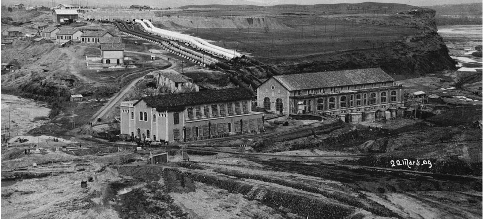
Construction de l'usine hydroélectrique en 1909 au quartier du Beynon
