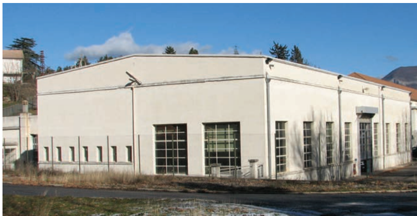
Atelier de la Base d'Intervention Mécanique EDF - 2012
