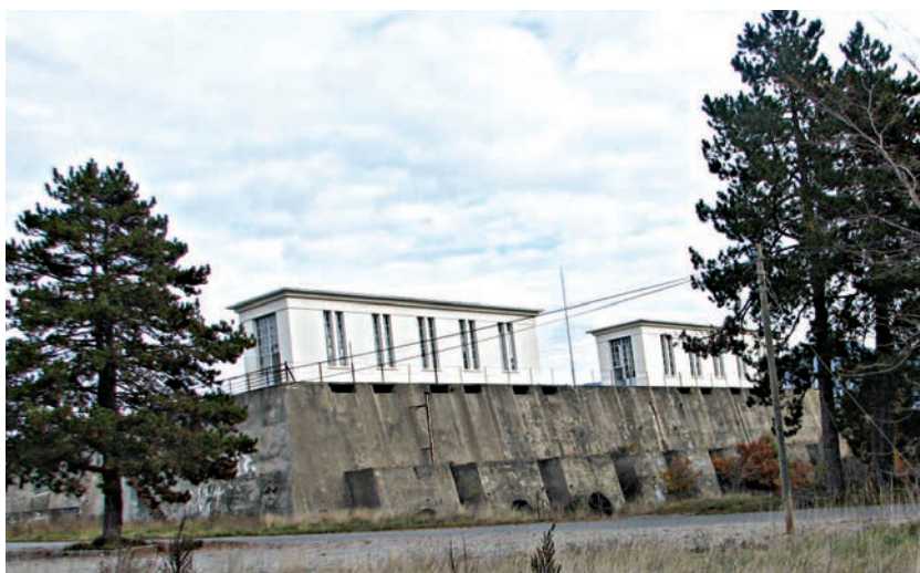
Patrimoine industriel, salle des vannes - 2012
