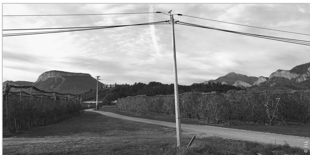
un «T» fixé sur les poteaux téléphoniques comme support de la fibre optique
