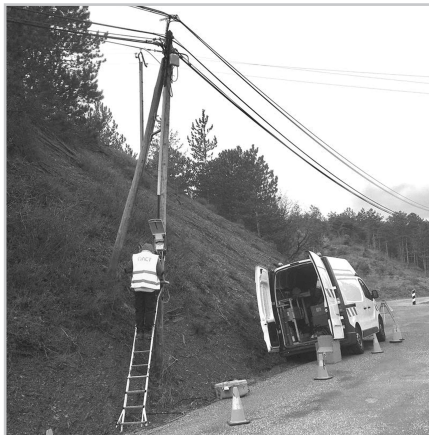
Installation d'un Point de Branchement Optique (PBO)
