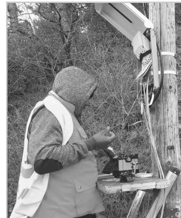
Installation d'un Point de Branchement Optique (PBO)
