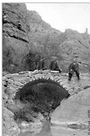
L'ancien chemin passant sur le vieux pont en pierre
