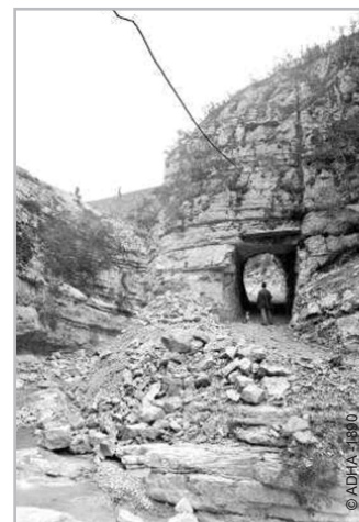
Le tunnel creusé par le RTM en 1890
