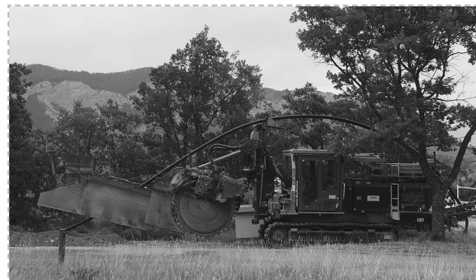
Tranchée pour ouvrir le terrain et enfouir la canalisation
