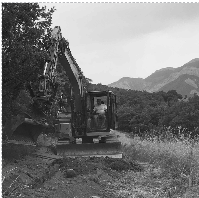
Remblaiement de la tranchée (Entreprise Polder)
