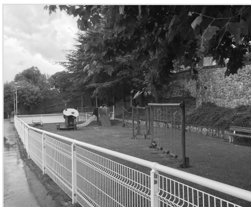
La clôture de l'aire de jeu, auparavant en bois, a été changée pour une structure métallique.
