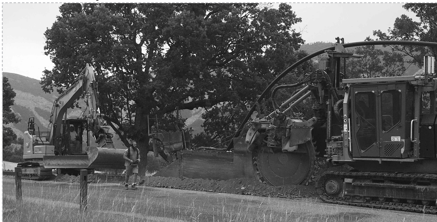
La trancheuse téléguidée au bord de la RD21
