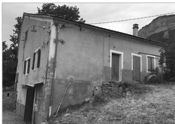
La maison d'école de Louis Giraud, dernière bâtisse (à gauche) du hameau de Faye en montant au col
