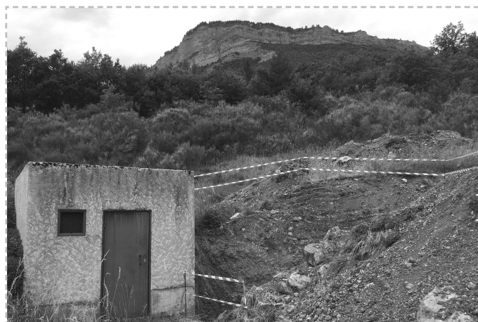
Réservoir d'eau de Faye
