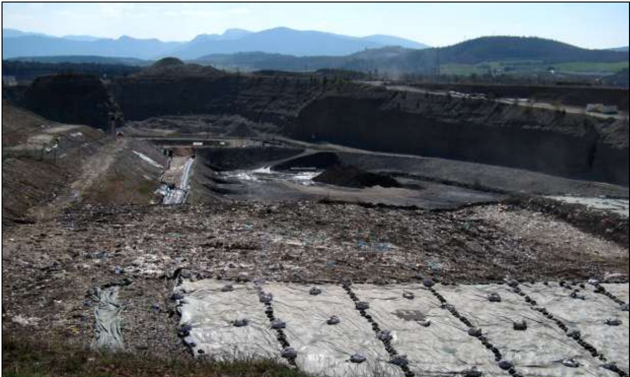
ISDND du Beynon casier en exploitation
